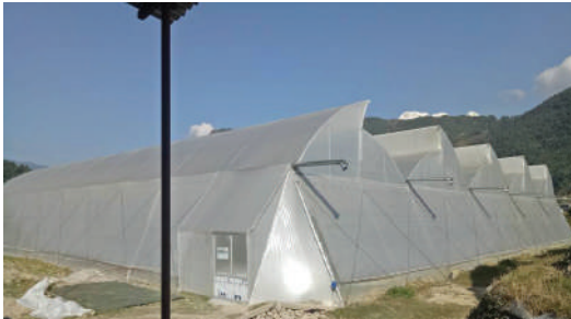
टप नेचुरल्ली भेन्टिलेटेड प्लाष्टिक घर, कास्की
